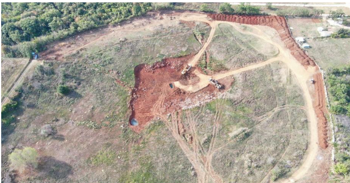
Slika: Područje Mala sjenokoša - Pulisoi radovi iskopa 29.8.2022. (Izvor: „Projekt zaštite od poplava sliva Rovinjski potok - Valtinjana: Povećanje volumena i uređenje retencije Mala sjenokoša - Pulisoi“)
