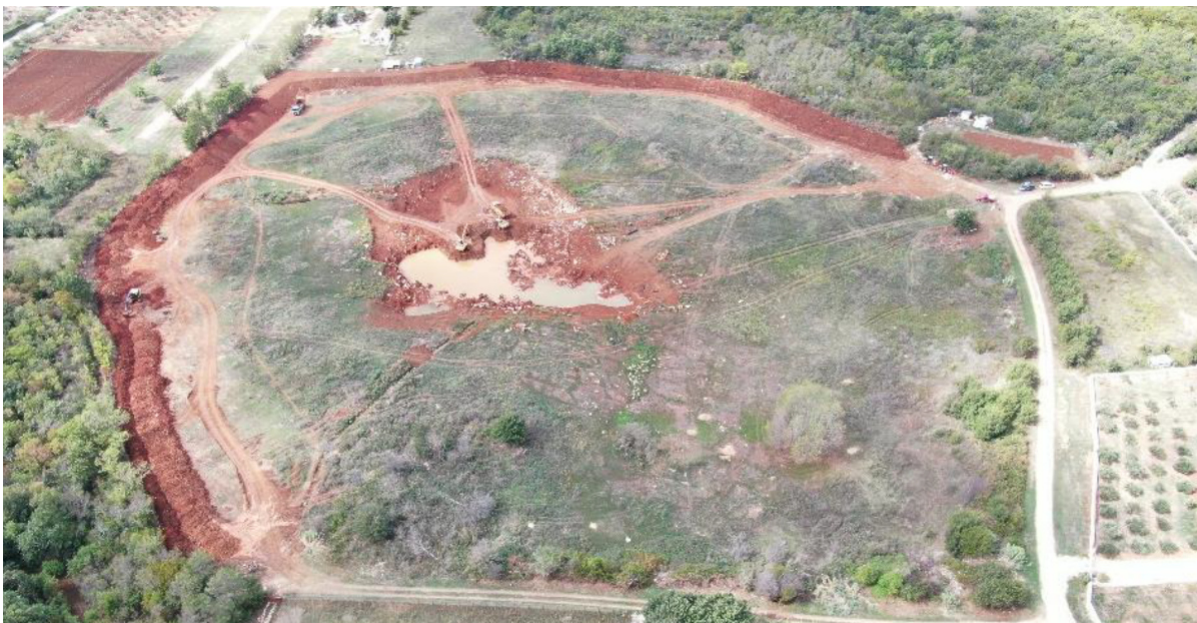
Slika: Područje Mala sjenokoša - Pulisoi radovi iskopa 9.9.2022. (Izvor: „Projekt zaštite od poplava sliva Rovinjski potok - Valtinjana: Povećanje volumena i uređenje retencije Mala sjenokoša - Pulisoi“)
