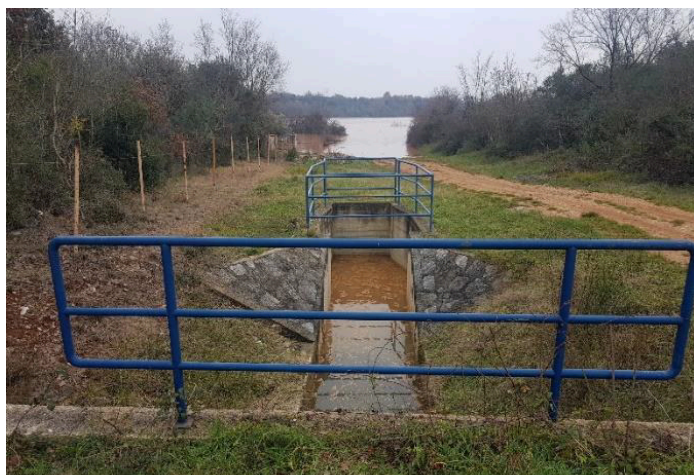
Slika: Dovodni kanal do depresije Mala sjenokoša dana 19.12.2020.
