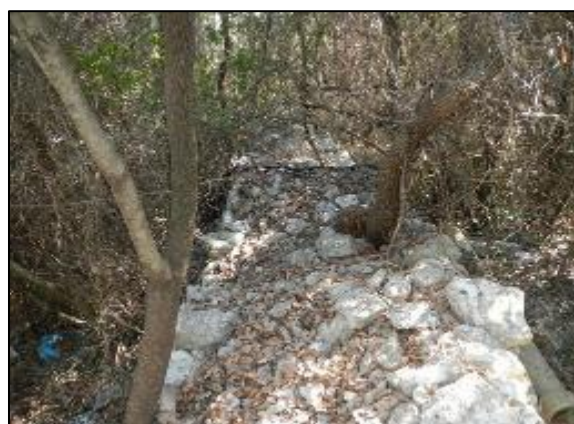
Slika 54. Suhozid obrastao gustom vegetacijom na lokaciji
