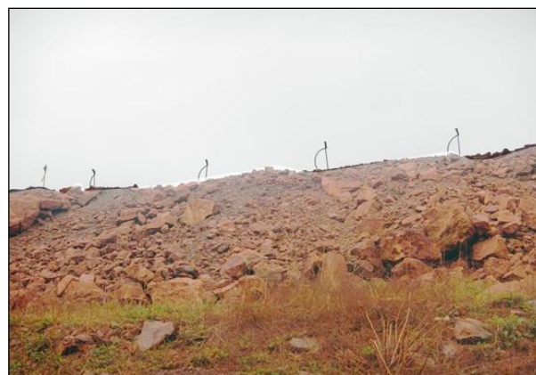
Slika 11. Otprašivanje jalovišta vodom s prskalicama na stupovima
