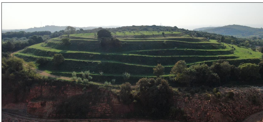
Slika 65. Deponija komunalnog otpada Bazilika u ožujku 2023. g.
