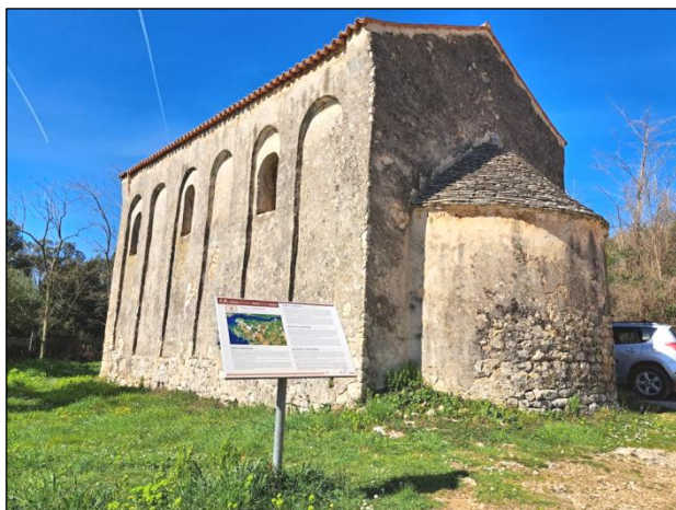
Slika 60. Južno pročelje Crkve sv. Krištofora
