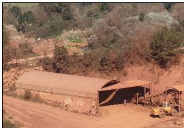
Slika 51. Nadstrešnica za deponiranje prerađenog boksita za otpremu
