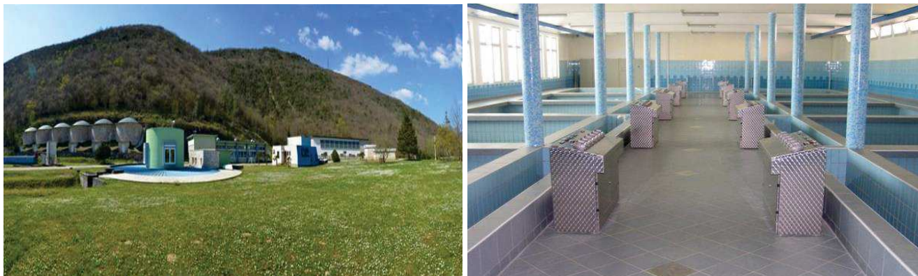
Slika 5: Objekti i postrojenja Vodovoda Pula d.o.o. za vodne usluge
