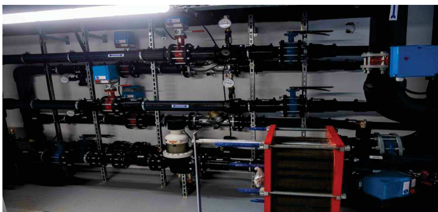
Slika 1: Novo postrojenje u Specijalnoj bolnici za ortopediju i rehabilitaciju “Martin Horvat” Rovinj – Rovigno koje kao primarni energent koristi morsku vodu
