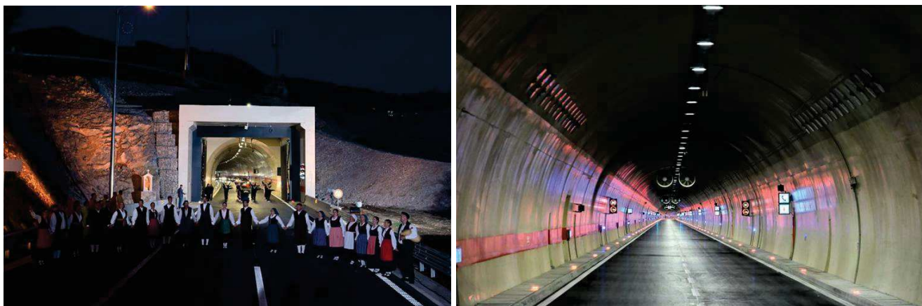
Slika 2: Tijekom 2024. godine dovršena je i svečano otvorena druga cijev tunela Učka duljine 5,63 km
