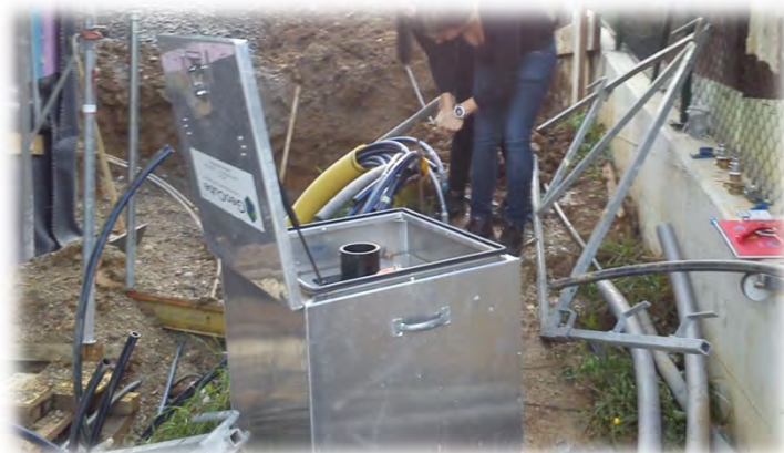
5. Giznik/Samobor – geokošare – obiteljska kuća 2013
