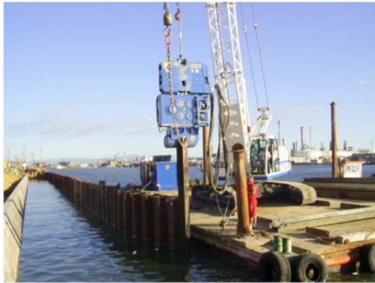
Figura 5.2: Infissione di Palancole a Mare
