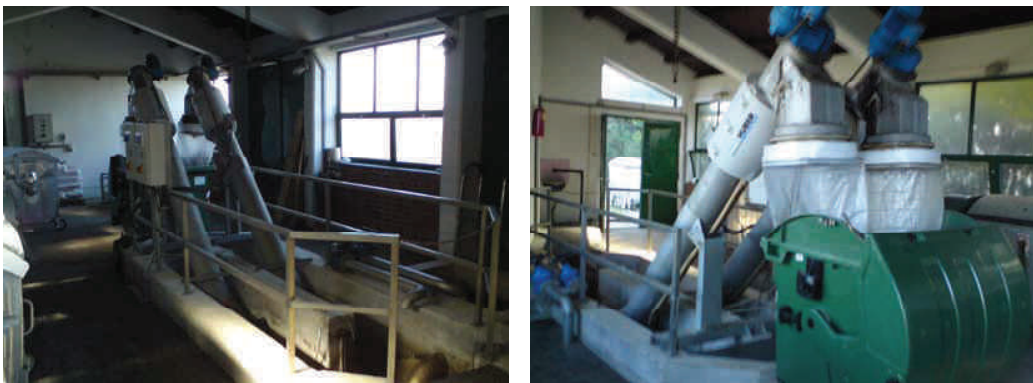
Sl. 1-7 Postojeće stanje izgrađenosti uređaja za pročišćavanje Debeli rt - 2
