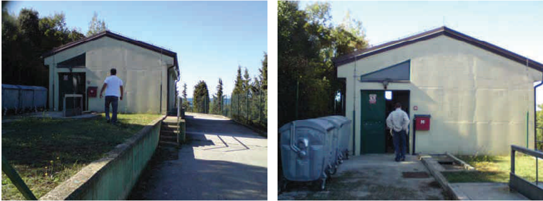
Sl. 1-6 Postojeće stanje izgrađenosti uređaja za pročišćavanje Debeli rt - 1
