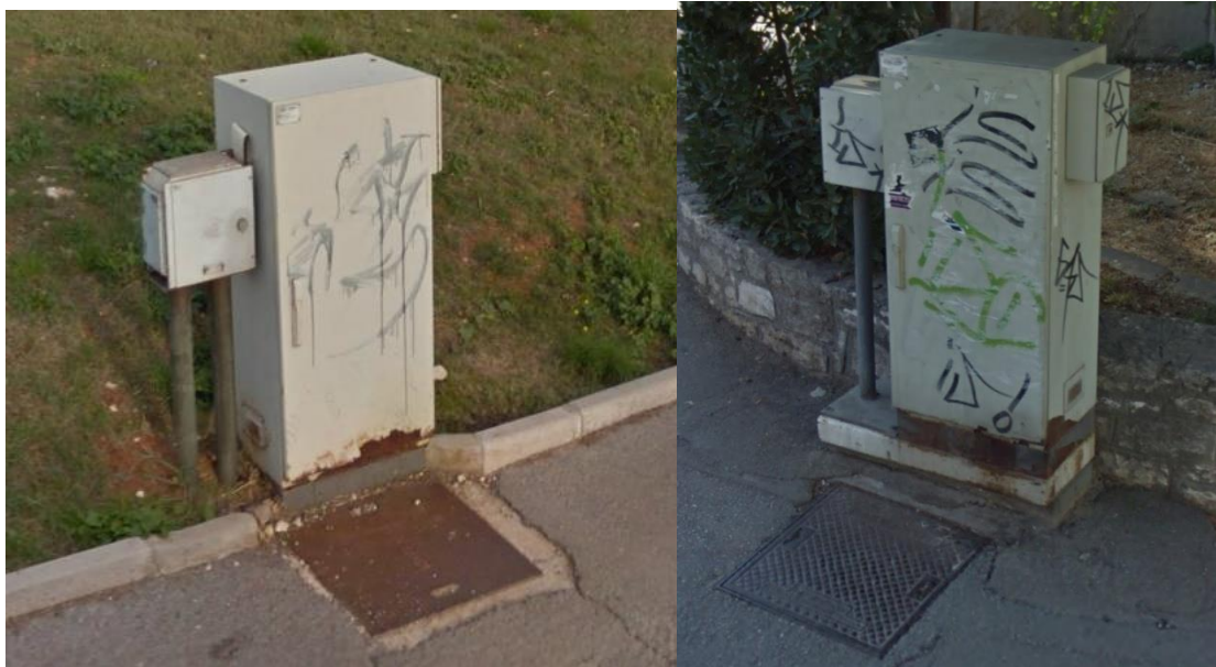
Fotografija 21. Korodirala kućišta semaforских uređaja
