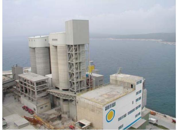
Sl. 7 Stanje građevinskih otvora mlinice cementa (otvorena vrata, razbijeni prozori)
