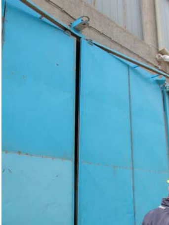
Sl. 6 Vrata u "zatvorenom" stanju s značajnim zračnim rasporom
